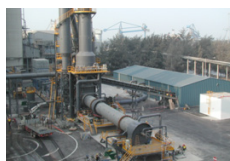
Завод по утилизации отходов
