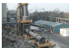
Завод по утилизации отходов
